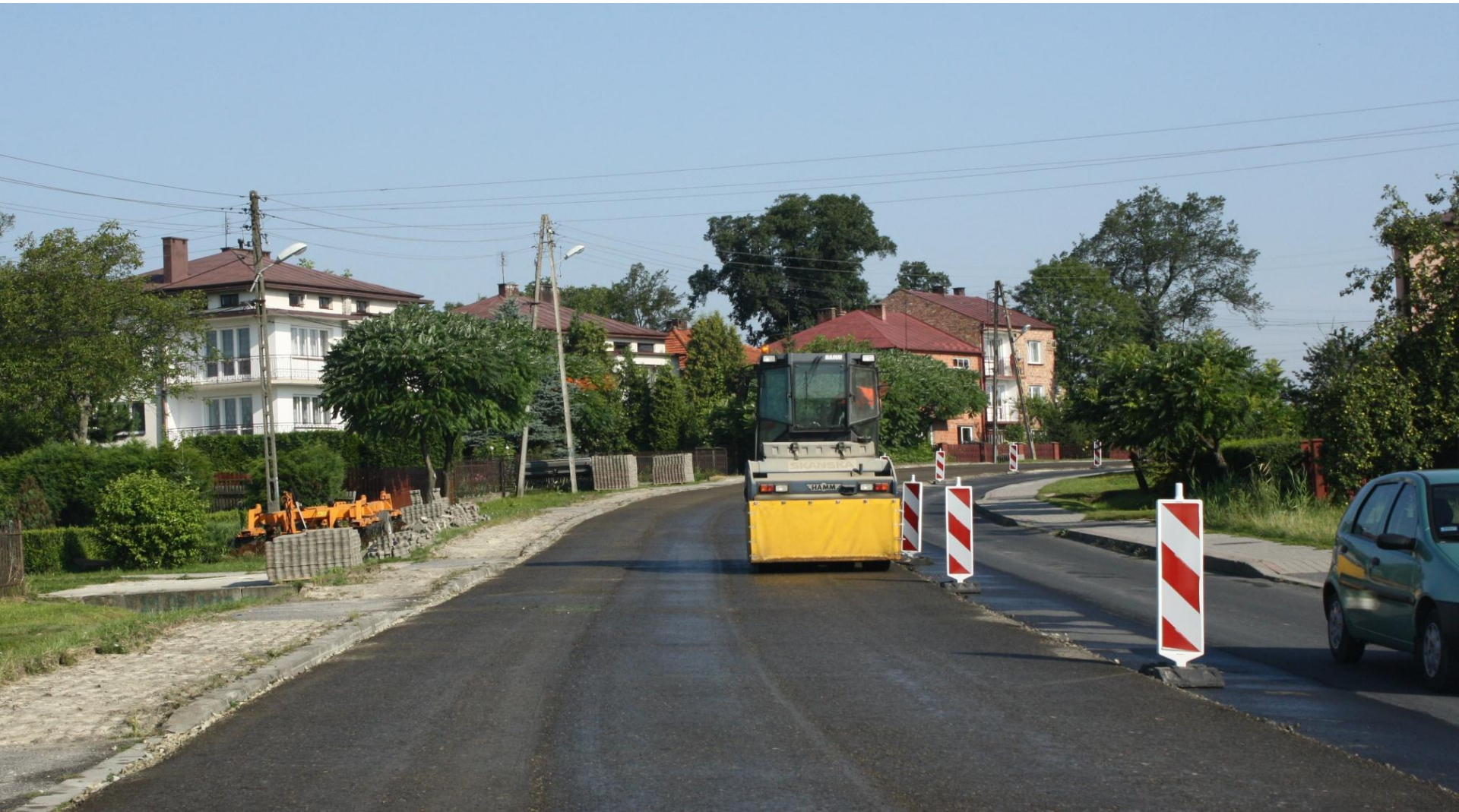
Zagęszczanie wykonanej warstwy
