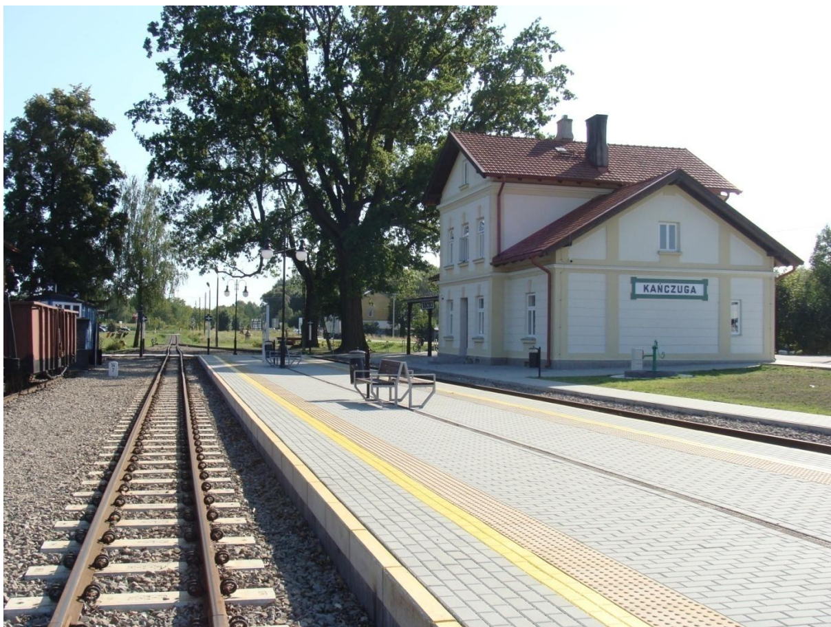
Rysunek 3. Stacja Kańczuga na zmodernizowanej z funduszy unijnych linii wąskotorowej Przeworsk – Dynów (źródło: Karol Trammer).
